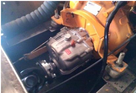
In het skûtsje is een nieuwe keerkoppeling geplaatst
